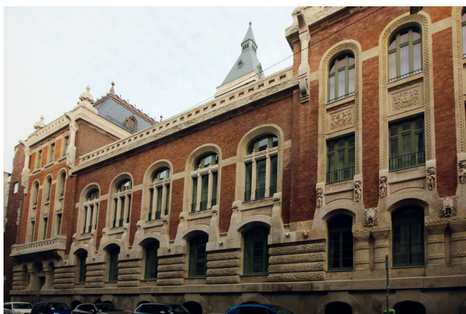
A Ray Rezső Vilmos tervezte telefonközpont száztiz éves épületének díszítőelemei a nemrég befejezett felújítás után is árulkodnak a ház eredeti funkciójáról (Fotó: Ludmann Mihály)
